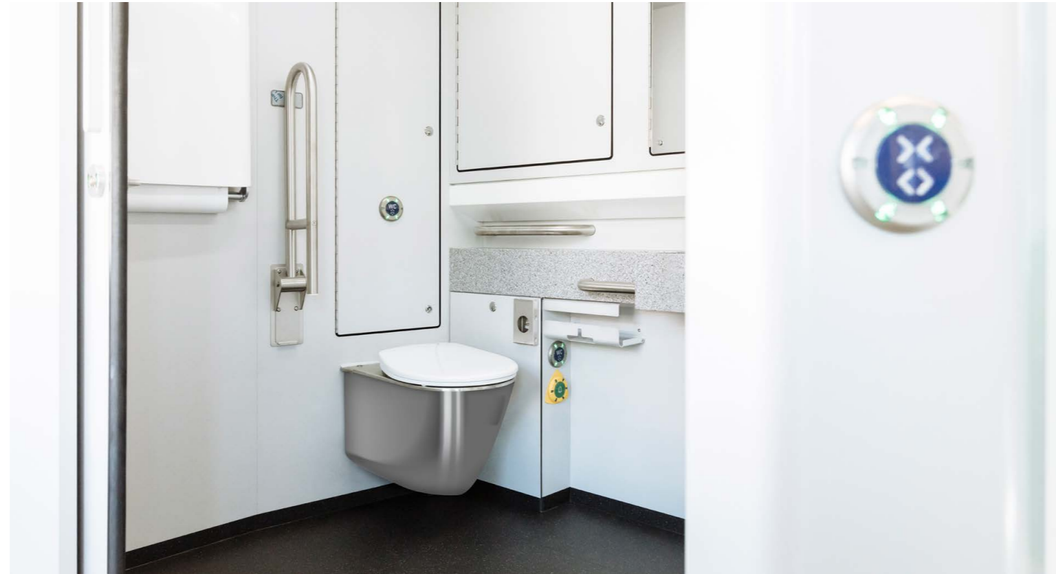
Blick in eine barrierefreie WC-Kabine.
