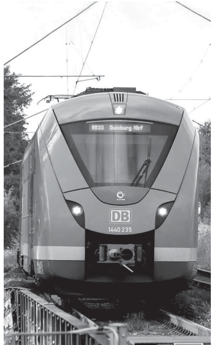
Ein Zug der Rhein-Niers-Bahn (RB33) überquert in Viersen-Rahser die Niersbrücke
