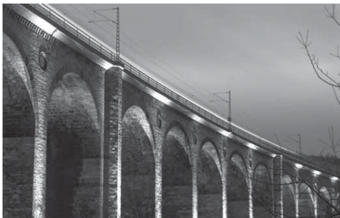
Der Altenbekener Viadukt in der Dämmerung Foto: DB AG/W. Klee
