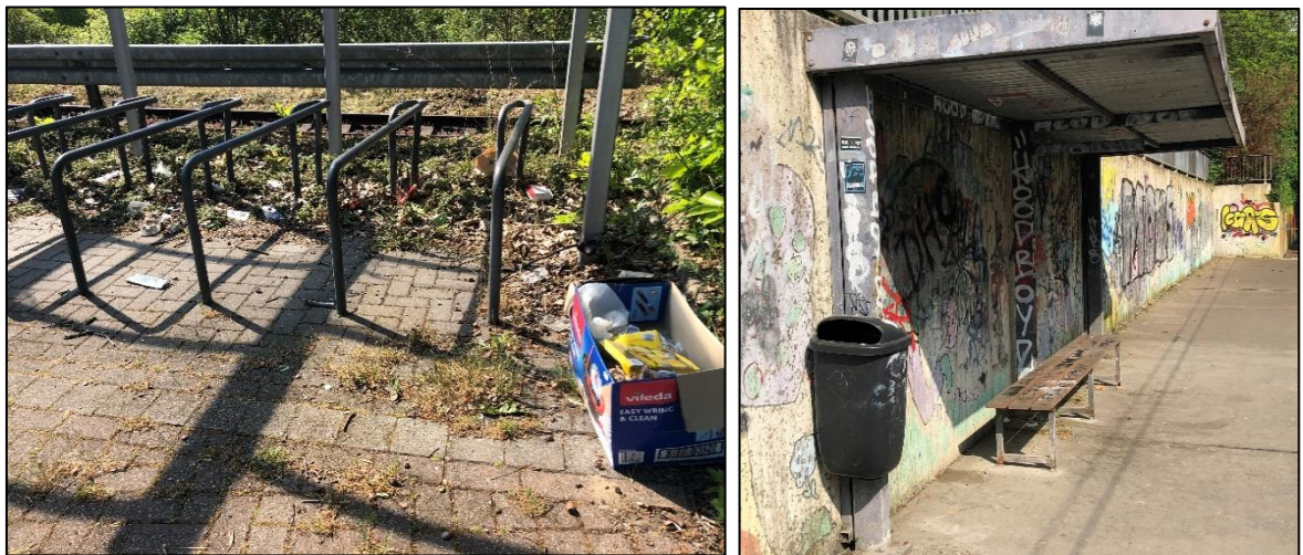
Abbildung 22: Beispiel mangelhafte Sauberkeit (eigene Fotos)
