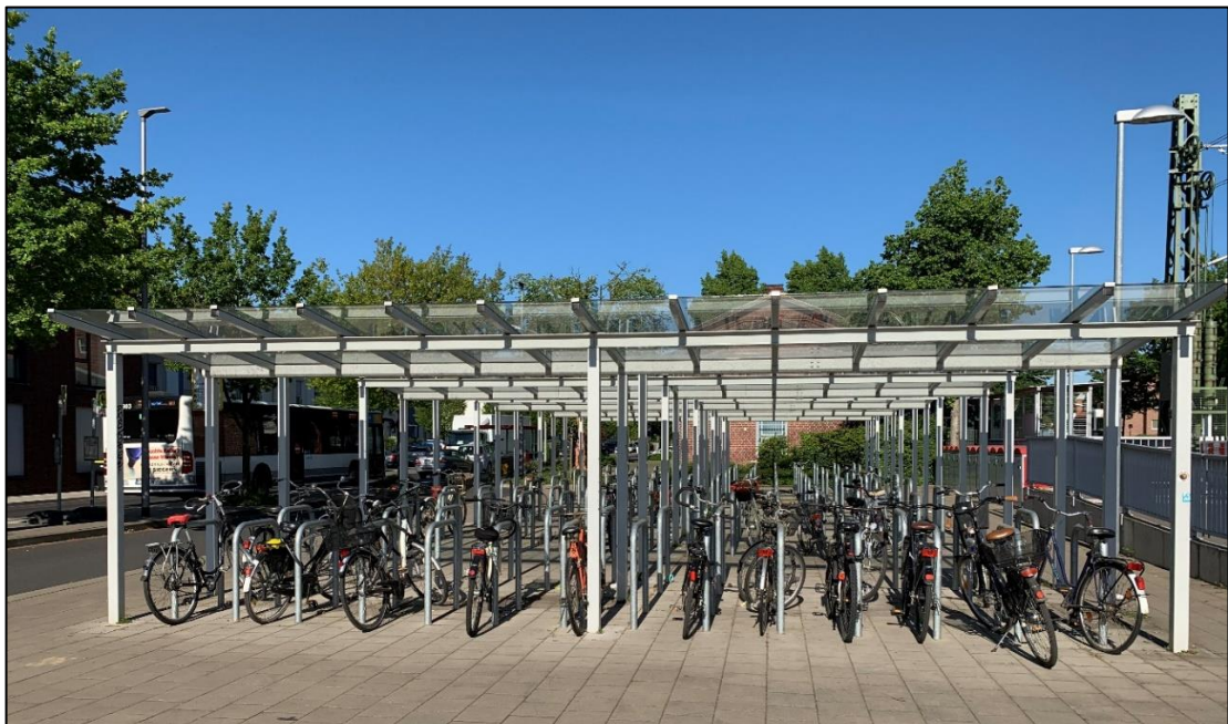
Abbildung 30: Beispiel B+R Anlage, Korschenbroich Bf (eigenes Foto)
