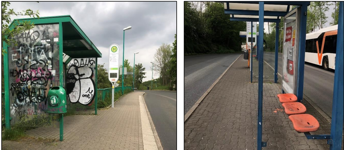
Abbildung 10: Beispiele mangelhafter Wetterschutz und Sitzgelegenheiten., Ennepetal Gevelsberg Bf (links), Gevelsberg Hbf (rechts) (eigene Fotos)
