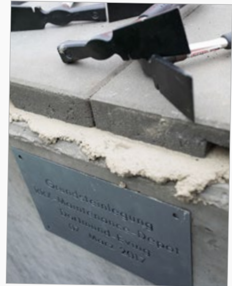
Grundstein der neuen RRX-Werkstatt in Dortmund-Eving
