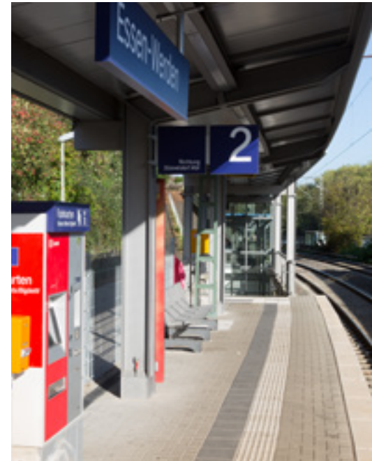
Im Zuge der Modernisierungsoffensiven investiert der VRR in den barrierefreien Ausbau von mittleren und kleinen Bahnhöfen.
