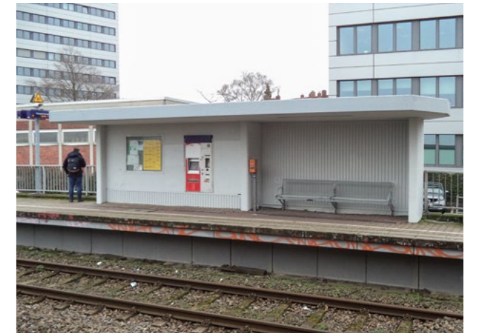
Wetterschutzhäuschen aus Beton in Dortmund-Körne West
