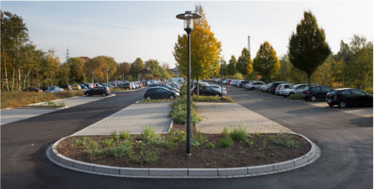
Die NRW-Zweckverbände wirken auf eine integrierte Verkehrsplanung im ÖPNV hin und stärken durch Förderanreize die Schnittstelle zum Individualverkehr, beispielsweise durch P+R-Anlagen mit dynamischer Beleggraderfassung.
