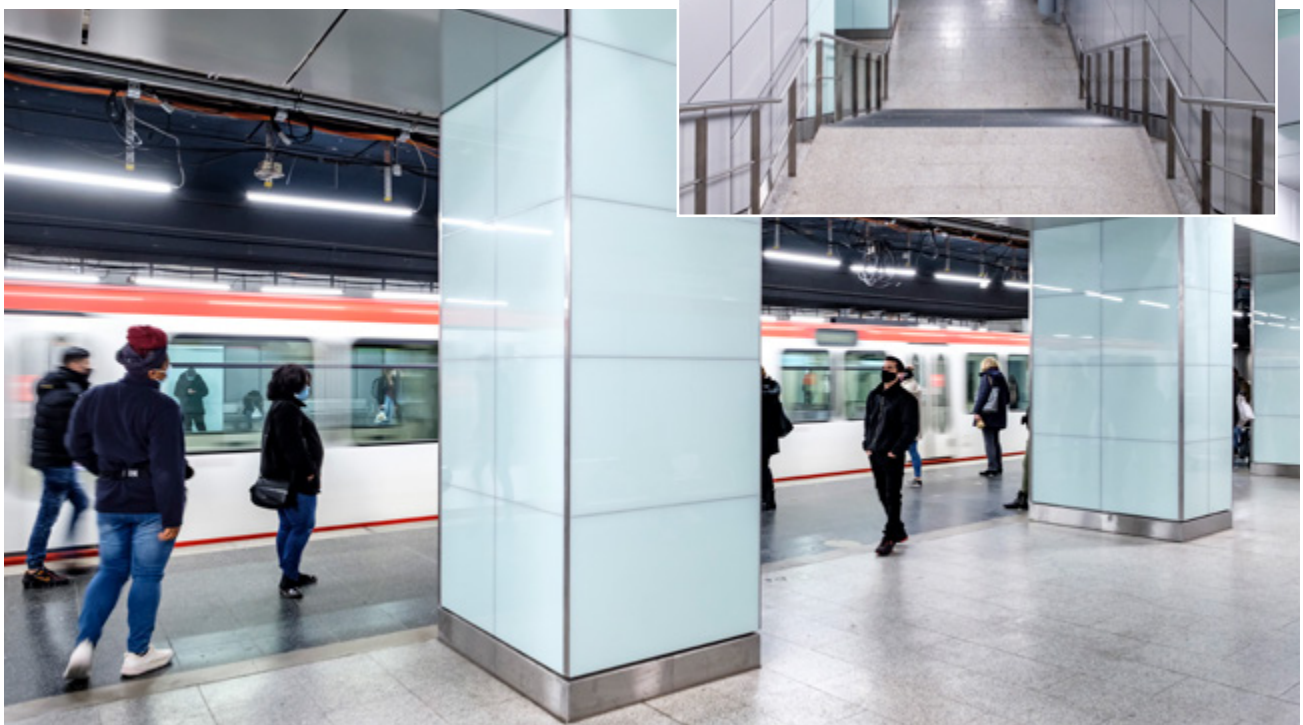
Um den Ansprüchen an einen modernen, leistungsfähigen und attraktiven Nahverkehr gerecht zu werden, modernisiert die Stadt Dortmund die Stadtbahnanlage unter dem Hauptbahnhof.
