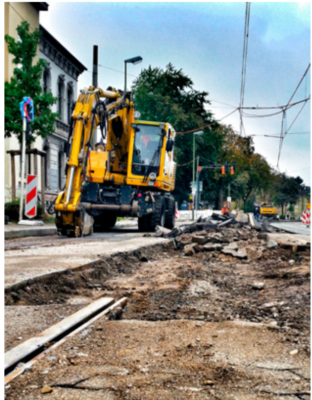
Die Kommunen und Verkehrsunternehmen in der Region erhalten Fördermittel nach § 13 ÖPNVG NRW, um ihre Stadt- und Straßenbahnnetze zu erneuern.
