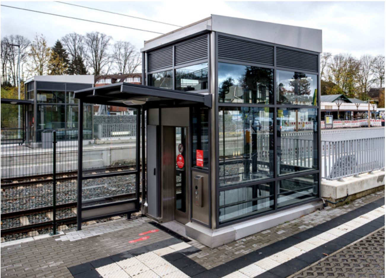
Mit dem Aufzug gelangen Nahverkehrskund*innen am Bahnhof Ratingen-Hösel barrierefrei direkt bis auf den Bahnsteig.
