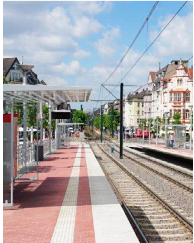
Die Stadtbahnhaltestelle Luegplatz in Düsseldorf wurde barrierefrei gestaltet. Sie fügt sich städtebaulich in das historische Umfeld an der Luegallee ein.
