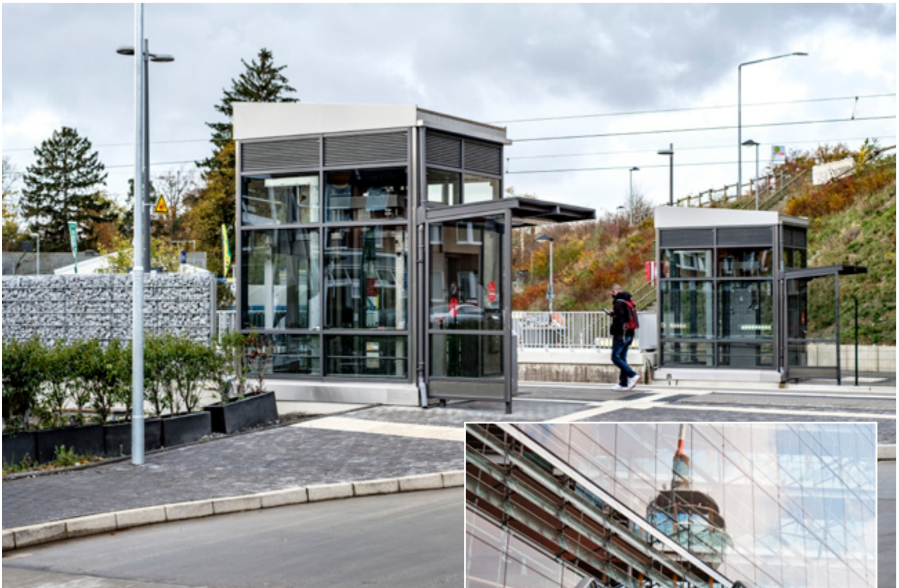
Der VRR fördert seit vielen Jahren die Modernisierung von Fahrtreppen und Aufzügen. Auch am Bahnhof in Ratingen-Hösel wurden die Anlagen erneuert.
